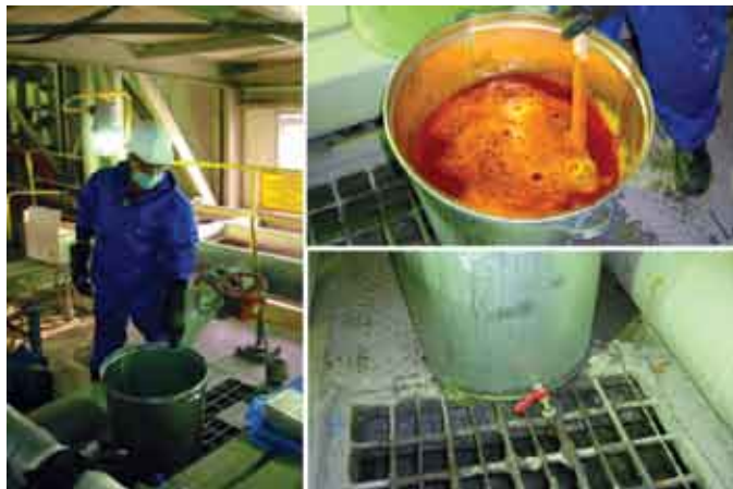
Рис.6 Введение люминесцентного раствора в систему циркуляции промывочной жидкости
