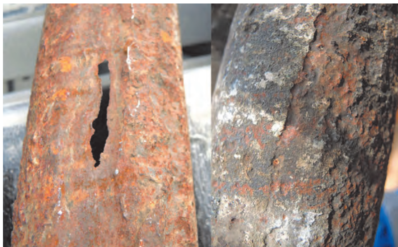
Рис. 7.7. Скважина Б. Слева – коррозия наружной поверхности НКТ под отложениями ИСО до сквозного повреждения; справа – отложения ИСО на внешней поверхности НКТ, коррозия под отложениями. Западно-Салымское месторождение, Нефтеюганский район, 2016 г.
