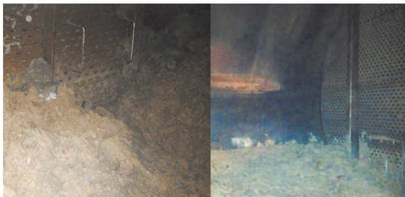
Рис. 1.16. Отложения в трехфазном сепараторе морской добывающей платформы ПА-Б.
