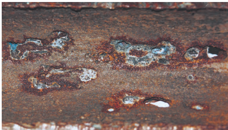
Рис. 1.6. Мейза-коррозия внутренней поверхности НКТ до сквозных отверстий. Глубина проникновения коррозии ~ 11 мм/год. Ай-Еганское месторождение (Нижневартовский район), 1998 г. Снижение дебита скважины в результате негерметичности НКТ
